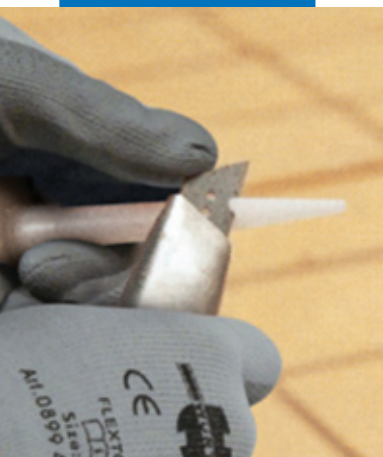
Отрезание носика в соответствии с размером швов
