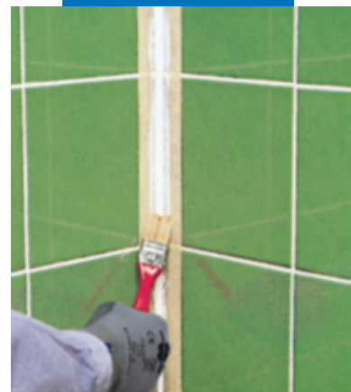
Заглаживание шва кисточкой, смоченной в мыльной воде
