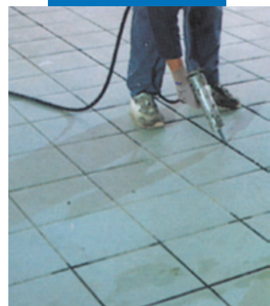
Герметизация швов в плитке посредством Mapesil AC
